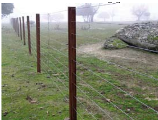
Recinzione elettrificata installata
