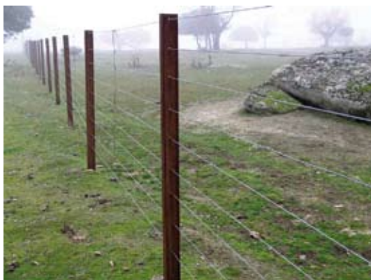
Recinzione elettrificata installata
